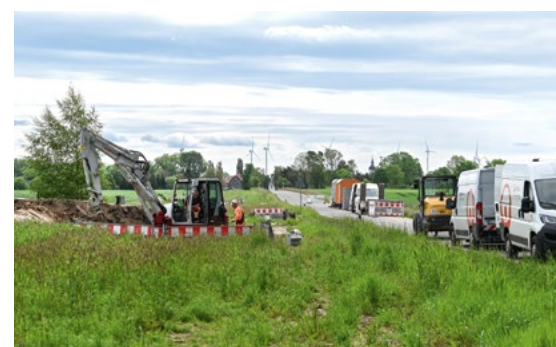
Zwischen Limbach und Leuben entsteht ein Teilstück der künftigen Nord-Süd-Trasse.
