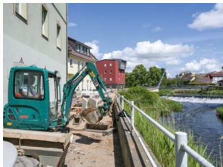
Gesperrt: Die Staupitzstraße in Döbeln an der Mulde ist seit Wochen Baustelle.
