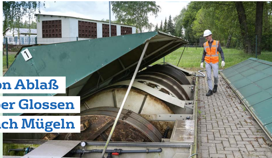
Sebastian Simon sieht auf der Kläranlage Ablauf nach dem Rechten.
