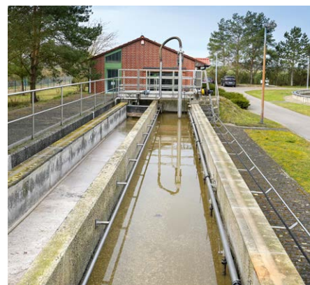
Schmutzwasser aus dezentralen Anlagen wird auf der Kläranlage Schlieben gereinigt.
