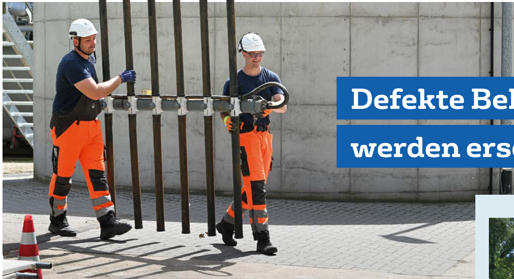
Andy Eberlein (li.) und Julius Janz transportieren ein defektes Belüfterelement ab.
