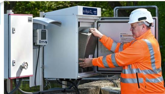
▲ Zu viel Phosphor im Abwasser, würde das Algenwachstum in den Flüssen beschleunigen. Deshalb werden die Werte auf der Kläranlage rund die Uhr online überwacht – und bei Bedarf angepasst.
