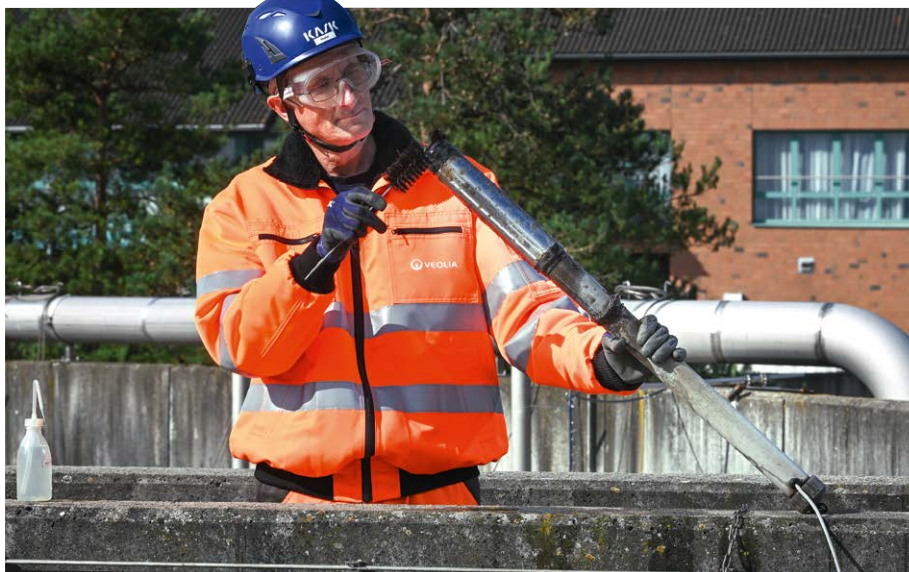
Veolia-Mitarbeiter Bernd Modler reinigt eine Sonde, die den Sauerstoffgehalt im Belebungsbecken ermittelt.
